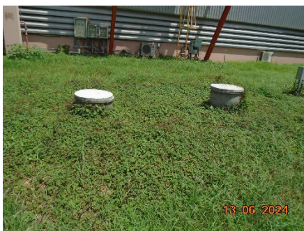
ภาพที่ 2-13 ถังบำบัดน้ำเสียสำเร็จรูป
